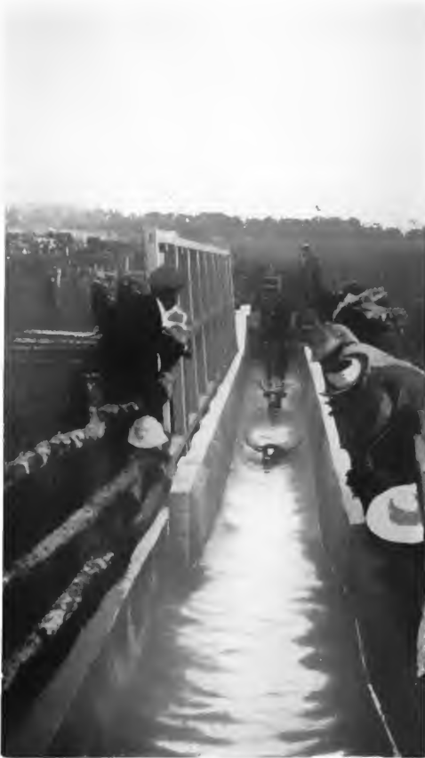
Agric. Journ. of the Cape of Good Hope 1906. Mc. Dougalls Rinderbad, 78 Fuß 6 Zoll lang. Schwimmbassin 71 Fuß lang, 6 Fuß 6 Zoll tief, mit einem Fassungsvermögen von 63 Gallonen.
